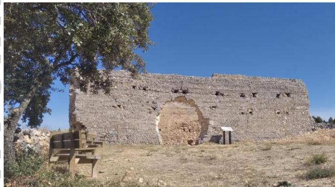
La edificación se compone de muros de cal y cantos además de alguna zona con sillares de caliza y arenisca.
